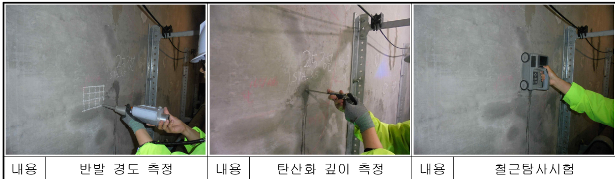
【사진 3.4】 문발SS인출 전력구 재료시험 전경
